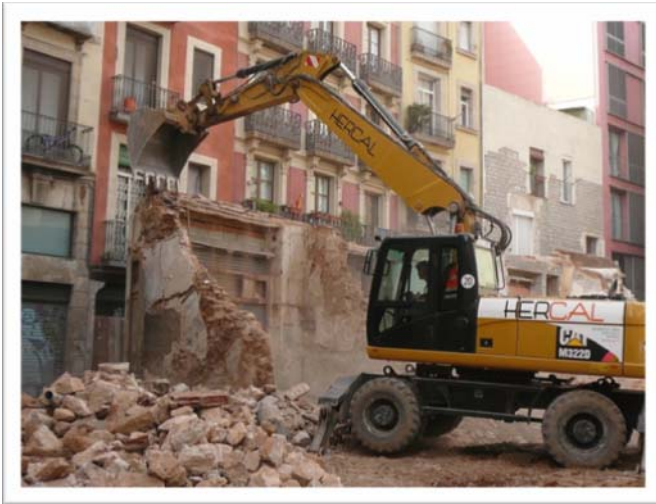
Procés d'enderroc de les mitgeres del carrer dels Mestres Casals i Martorell
