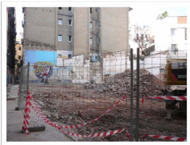
Foto del predi un cop realitzat el rebaix que afectava els paviments.
