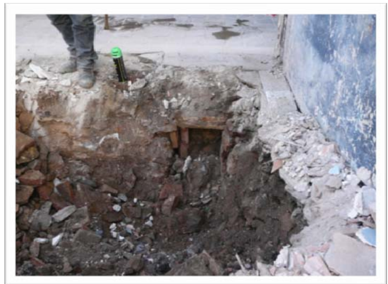
Rasa Ue 1000 a la zona del carrer del Mestres Casals i Martorell. Detall d'una de les escomeses
