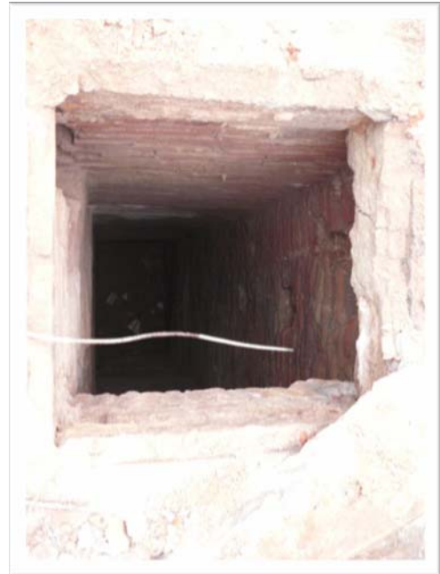
Imatges del pou de maons de planta quadrada documentat en el procés de l'enderroc.
