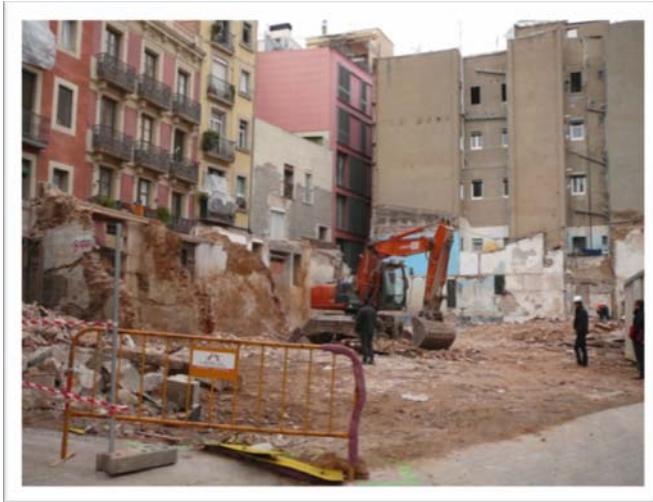
Foto del predi abans del rebaix que afectava els paviments
